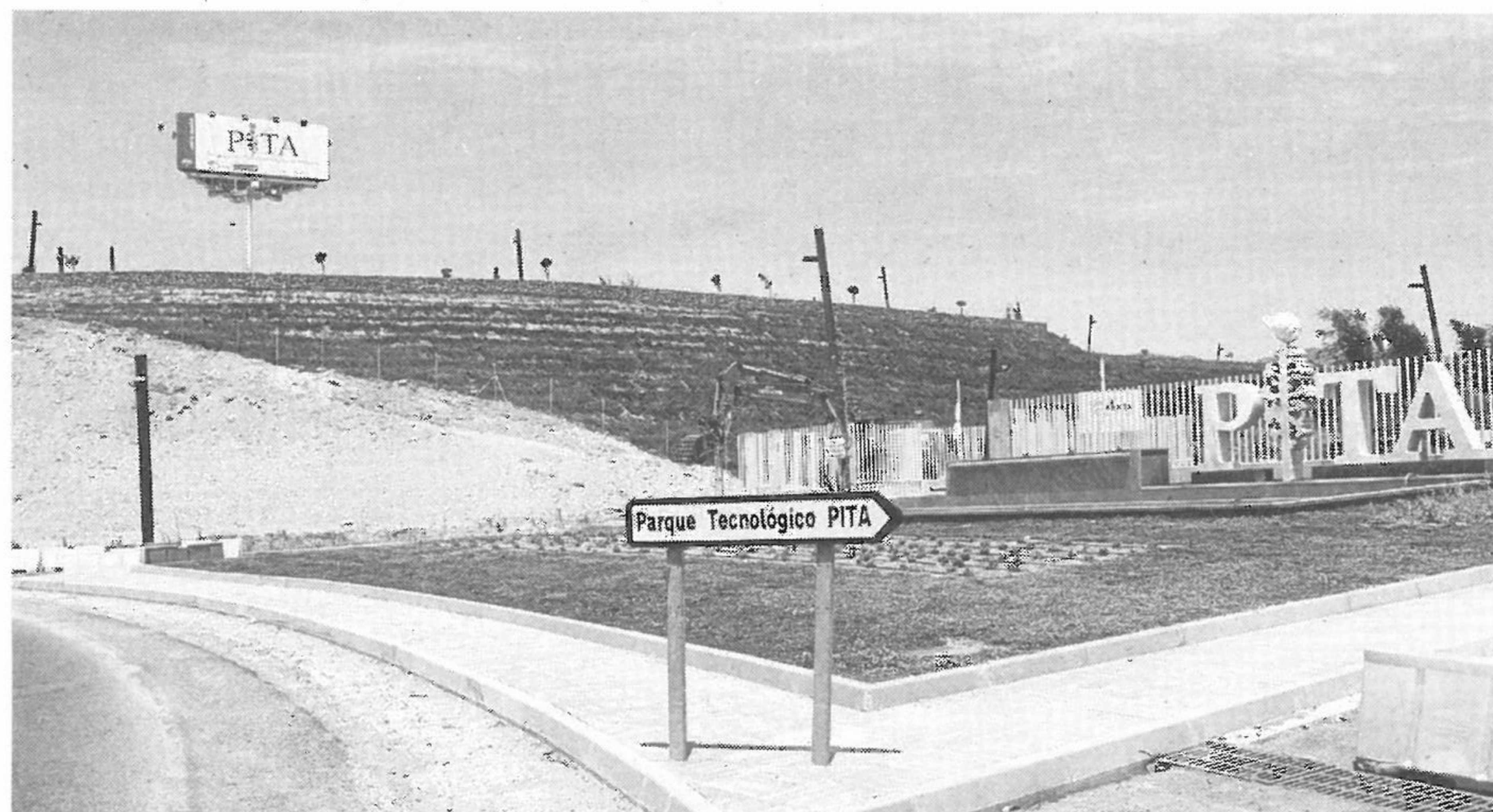
Estado de las obras de la tecnópolis a finales del pasado año.
