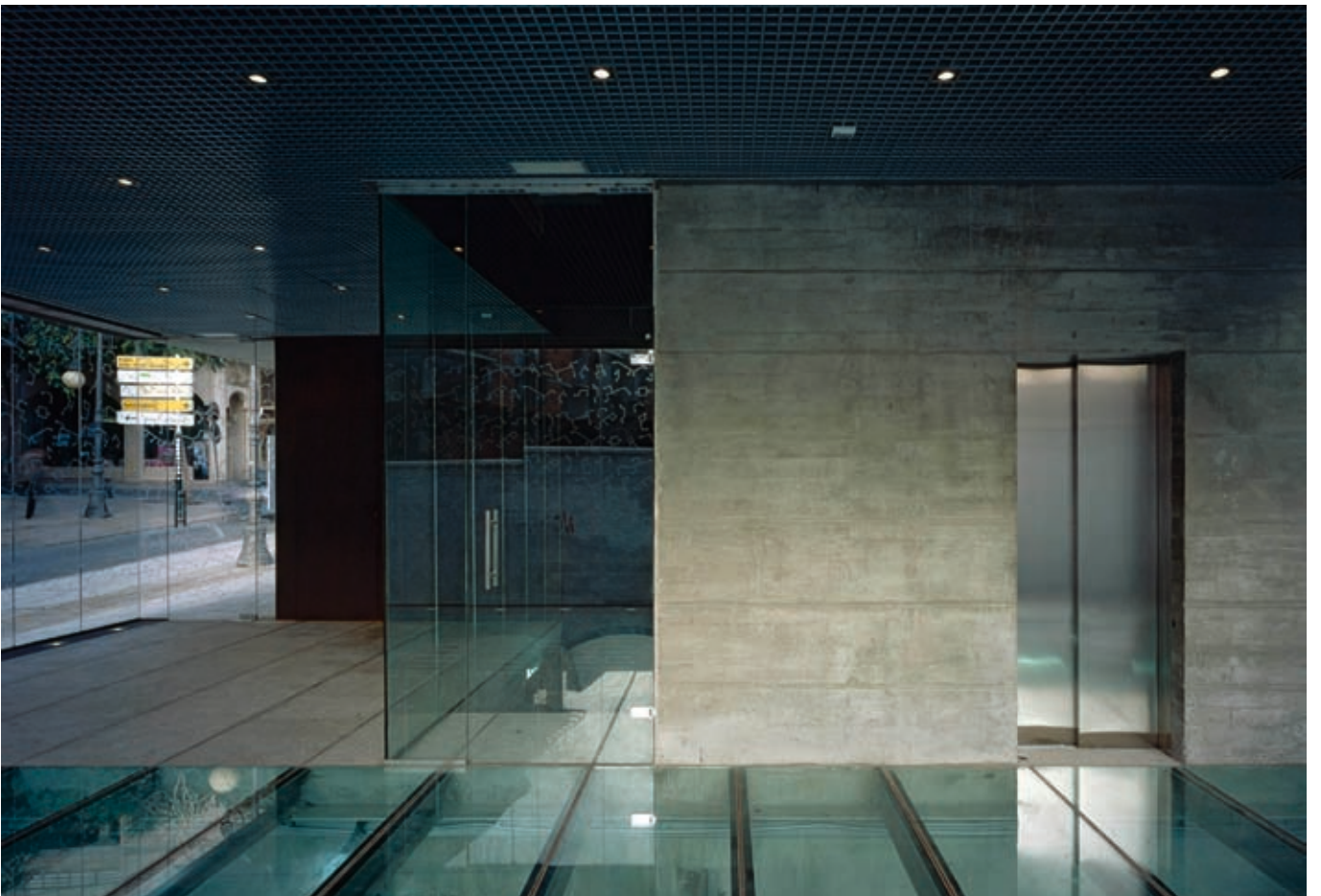
Interior del pabellón de acceso, con suelo de vidrio sobre restos arqueológicos. Foto: Jesús Granada
